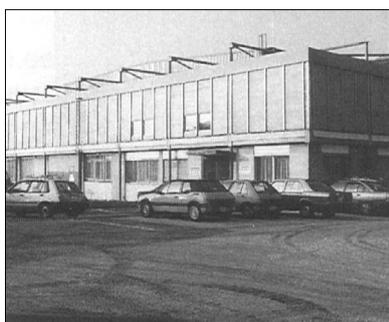
figure 19 · le pavillon de Max Bill pour l'Expo 1964 à Lausanne suivait un objectif réversibilité spatiale et technique (a). A l'issue de l'exposition, la plupart des modules ont été rachetés par des entreprises de construction pour en faire des halles de production. Une de ces parties a été démontée et remontée à deux reprises: d'abord à Yverdon, pour l'entreprise *Arkina*, puis à Yvonand par l'entreprise de construction *Geiliger* (b) (Gilliard 1992).
